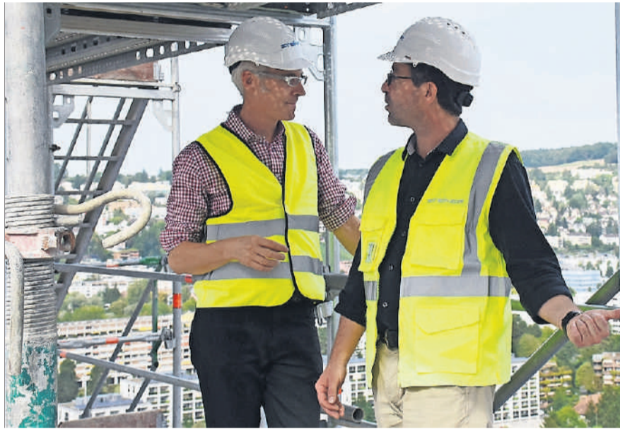
Bautreuhänder Marc Petitjean (l.) und Florian Kowanda, Projektleiter bei der Steiner AG, zeigten «Zürich West» die Baustelle.
