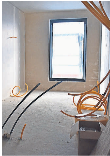
Ein Hotelzimmer im Rohbau: Hier soll «A-ja City Resorts» einziehen.
