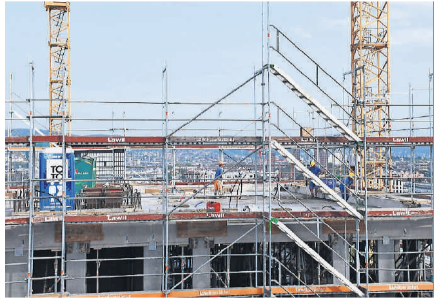
Die grösste Herausforderung stellt die Sicherheit dar. Bereits eine Schraube, die aus dieser Höhe hinunterfällt, kann gefährlich werden.
