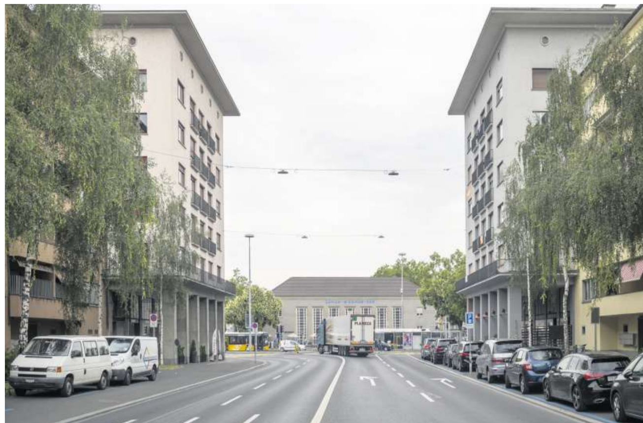
Ein schönes Stück Stadtplanung: Die Achse vom Sihlhölzli zum Bahnhof Wiedikon wird von zwei markanten Eckbauten flankiert.
