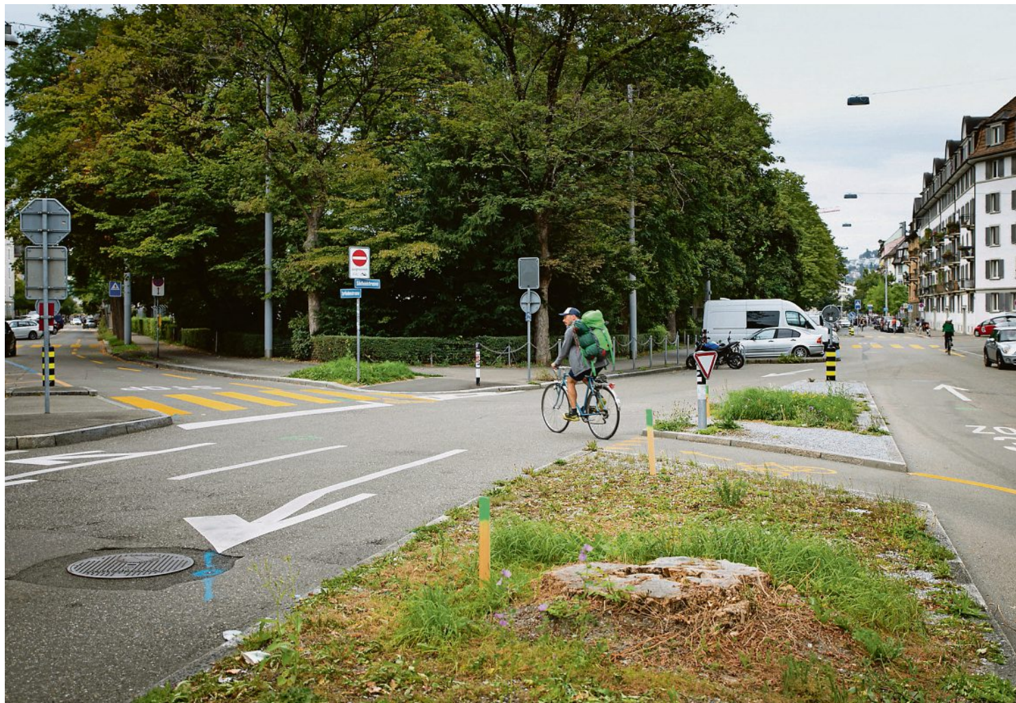
Sackgasse statt Durchfahrt: An dieser Stelle soll der neue Quartierplatz entstehen. Foto: Fabienne Andreoli
