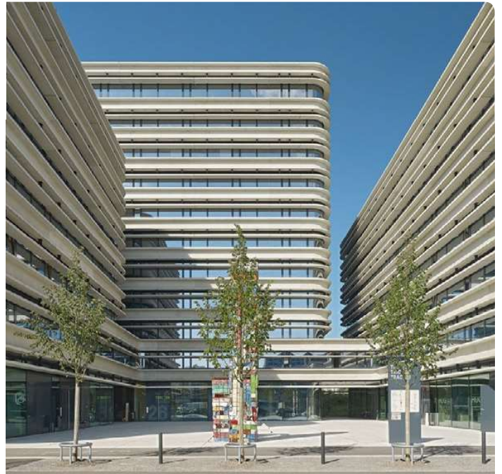
Das neue Gesicht des pulsierenden Arbeitsorts Wiedikon: Das Geschäftshaus «Tic Tric Trac» im Binz-Quartier. Bild: PD
